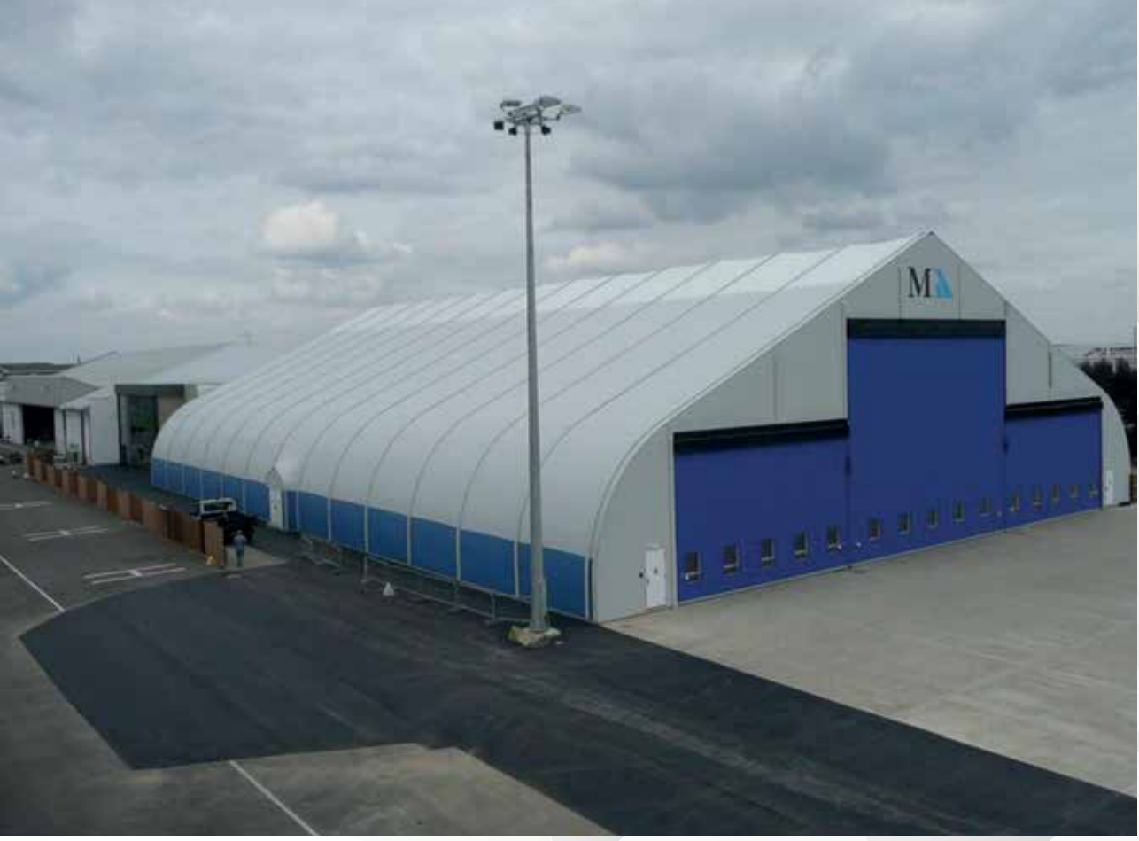
Depo - Hangar Çadırı
